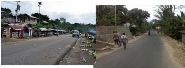
Gambar 4. Infrastruktur Jalan di Kecamatan Ende
