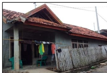
Gambar 2. Kondisi salah satu rumah responden, Pekerjaan TKI, Pendapatan ≤Rp.3 Juta Perbulan, Pendidikan Akhir Perguruan Tinggi
